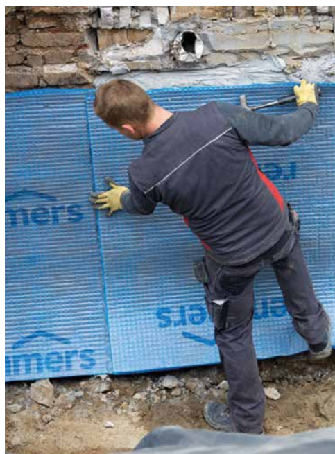
Anbringen von DS Systemschutz an der Außenwand.
