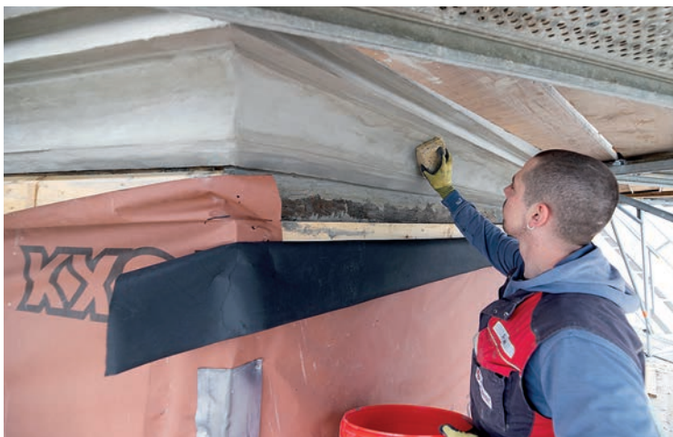
Die Gesimse am Turm wurden mit dem Betofix-System fachgerecht reprofiliert.
