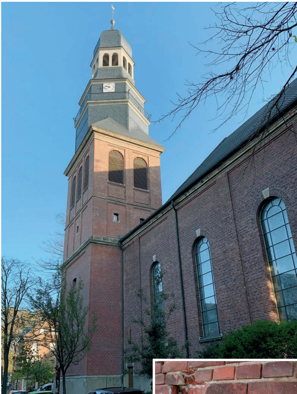
Der Turm der denkmalgeschützten Liebfrauenkirche im nordrhein-westfälischen Bocholt wurde komplett instandgesetzt.
