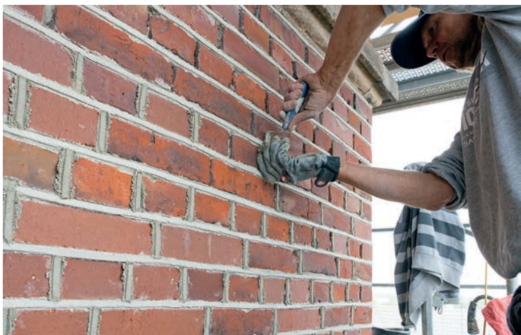
Für die originalgetreue Neuverfugung mischten die Verarbeiter zwei verschiedene Farbtöne des Trass-Kalk-Zement Fugenmörtels FM TK.
